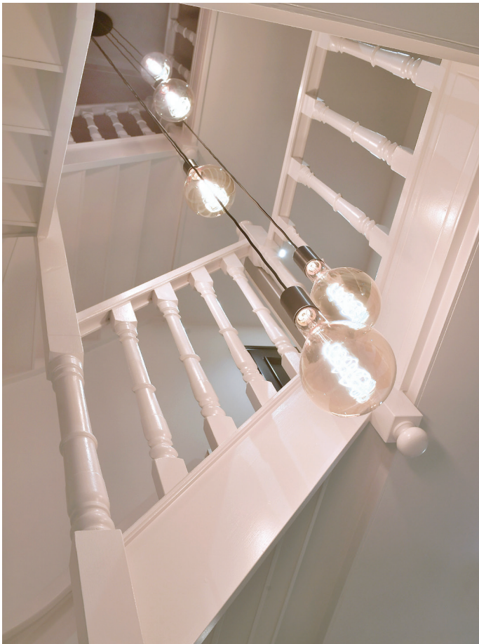
De gehele e-installatie werd aangelegd door TuBo elektro.
